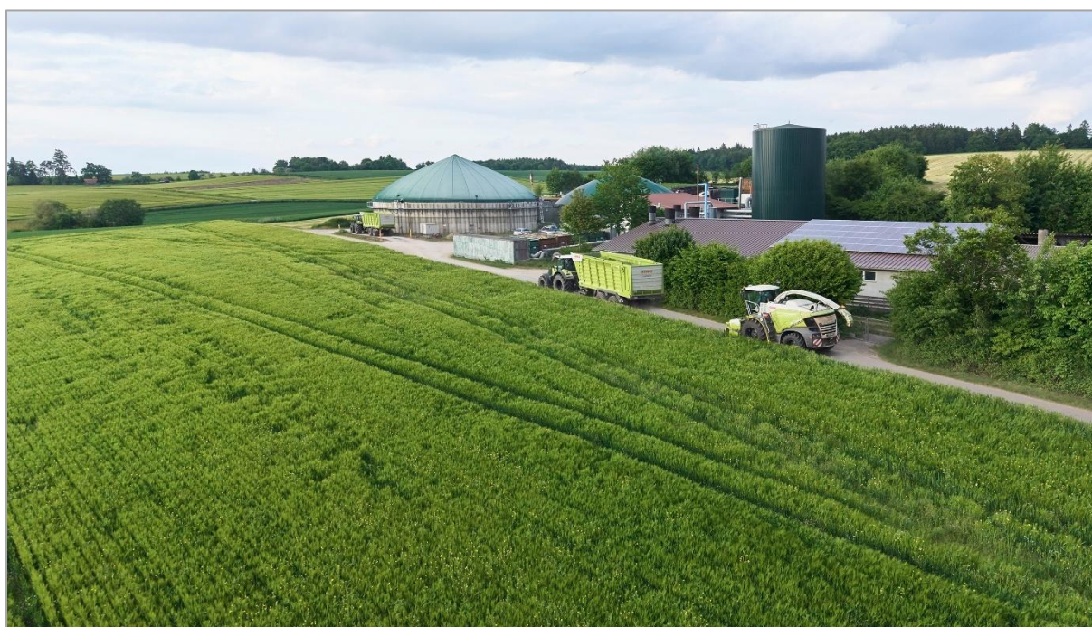
Abbildung 15: Biogasanlage Bioenergie Rottal GmbH in Orsenhausen, Schwendi
